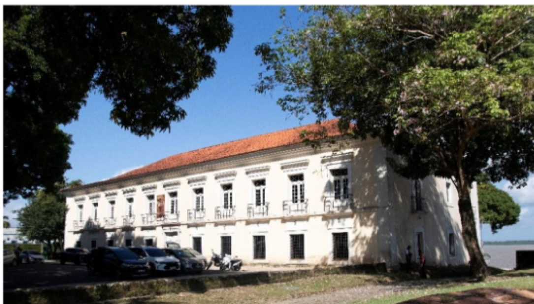
Figura 1: Fachada Principal do Espaço Cultural Casa das Onze Janelas.
