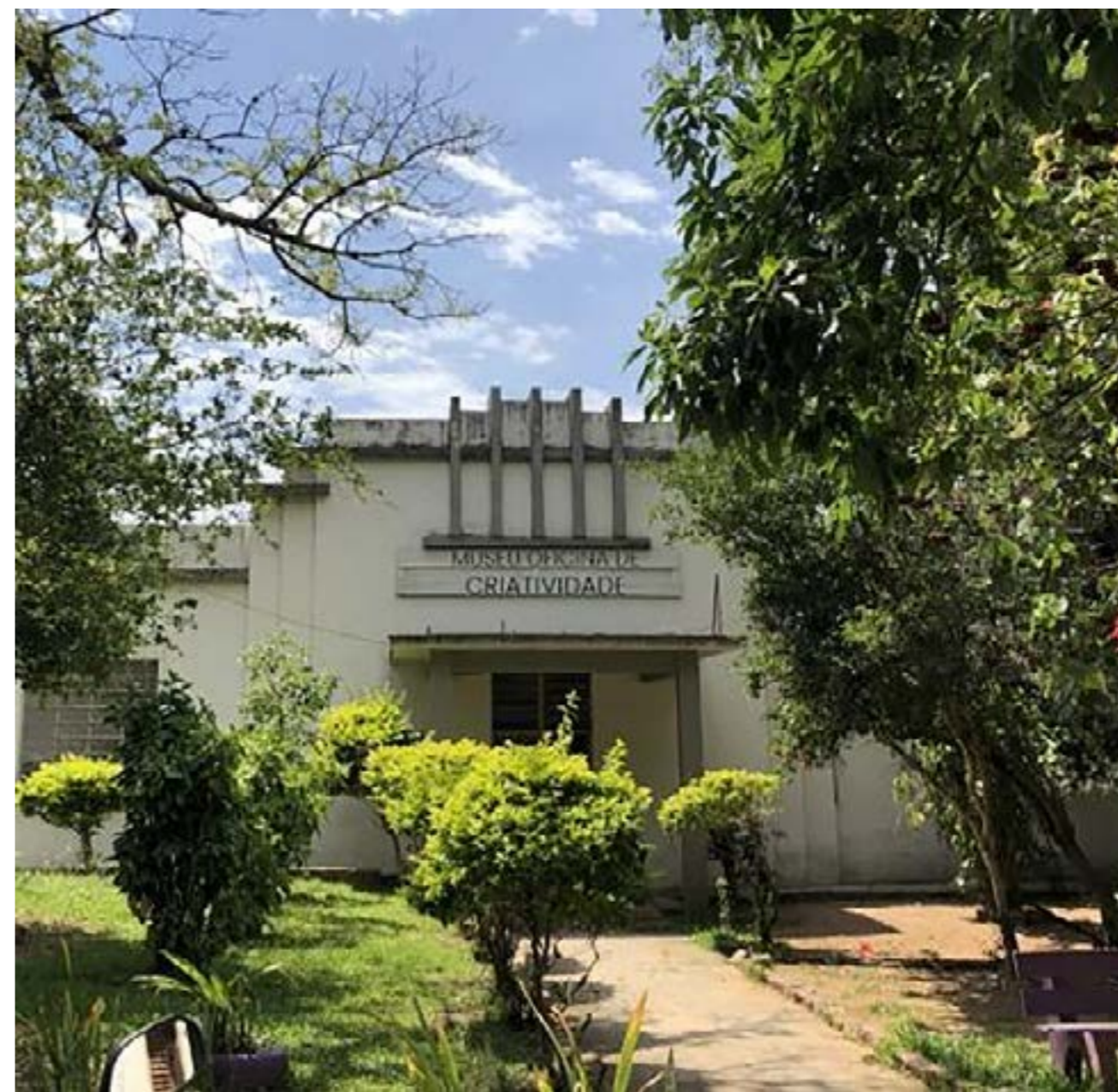
Figura 2; Prédio do MEOC-HPSP - Foto: Julia Ferreira
